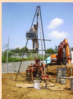
ボーリング調査
