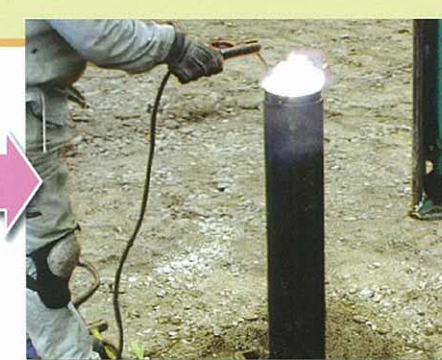
■スリーブ溶接
