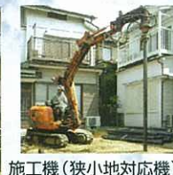
施工機(狭小地対応機)
