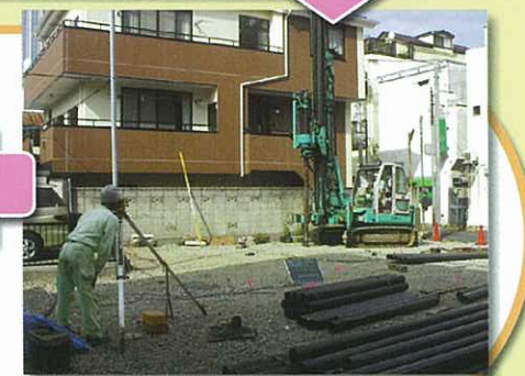
■杭頭レベル調節
