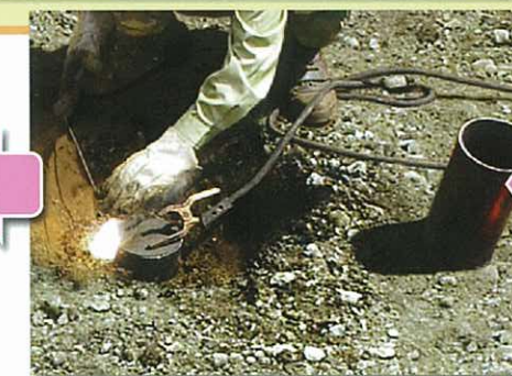
■杭頭プレート
