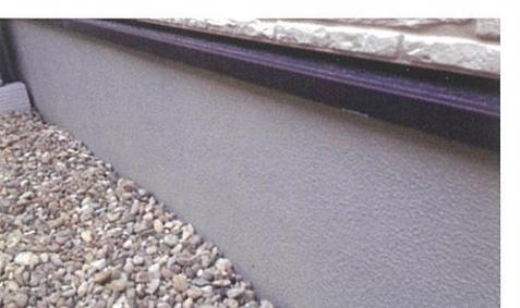
202タイプ(砂骨ローラーで施工)
