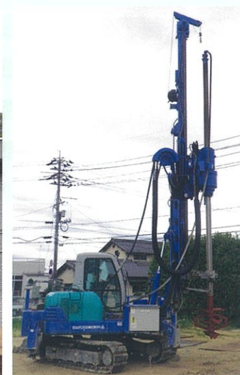
施工機械(10t級)
