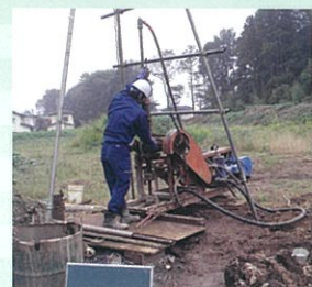
コアボーリング
