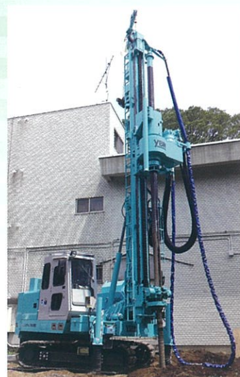
施工機械(15t級)
