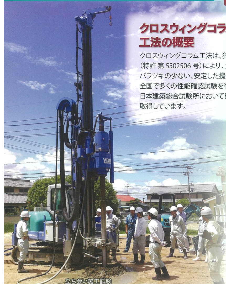
立ち会い施工試験
