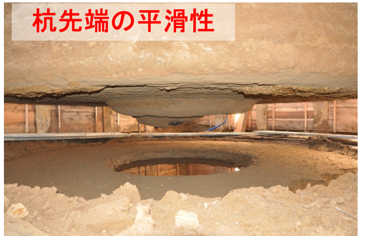
掘出し後の杭先端状況 φ5500
