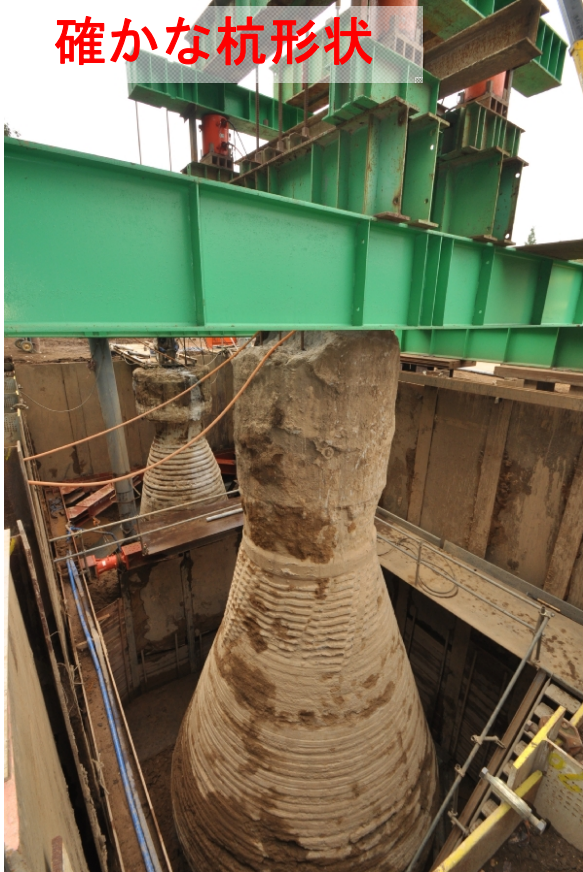
拡底径φ5500の掘出し
