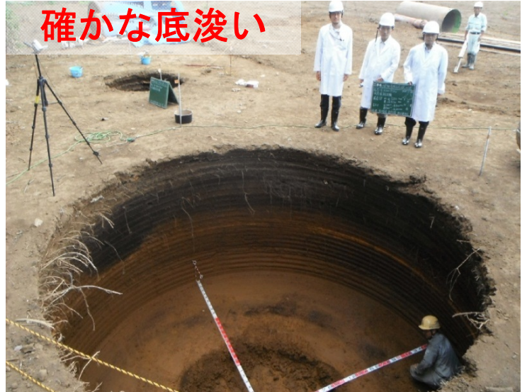
浅層掘削後の状況 φ5500
