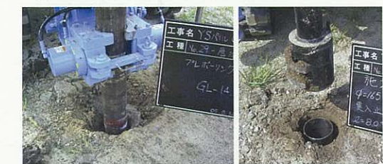
●回転貫入施工
